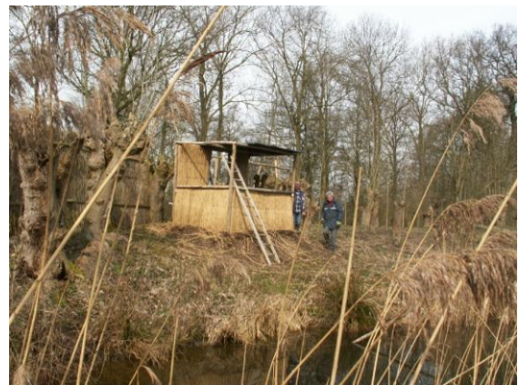
De bouw van de vogelkijk hut
